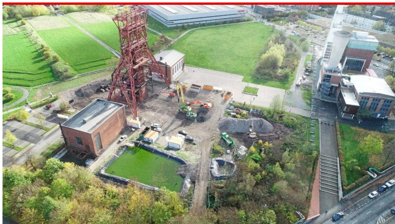
700 Tonnen, entspricht 34 Sattelzug-Ladungen, an Gesteinsrückständen wurden beim Abriss der Hängebank unter dem Fördergerüst der Zeche Consol im ehemaligen Kohlebunker vorgefunden.
